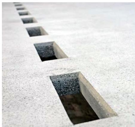
Ausfräsungen der Verbindung in der CPC-Brückenplatte.
