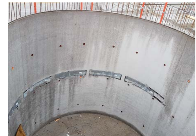
Abb. 1.4.6 Sichtbeton Treppenhaus aus R-Beton mit Gesteinskörnung Typ 2
