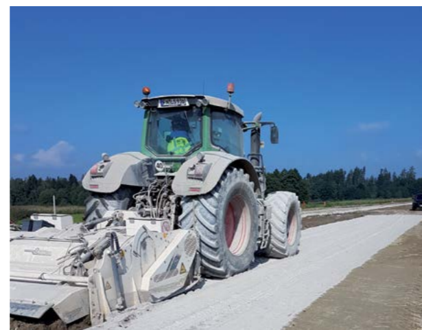
Abb. 8.18.3 Maschine beim Ausstreuen von Bodenverfestigungsmaterial
