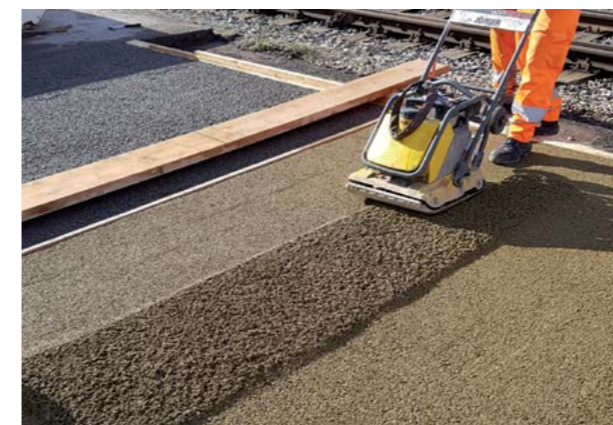
Abb. 7.11.5 Holcim CampoDrain Handeinbau und Verdichtung
