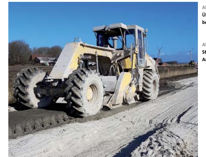
Abb. 8.18.10 (links) Übergabe von Bodenverbesserungsmaterial
