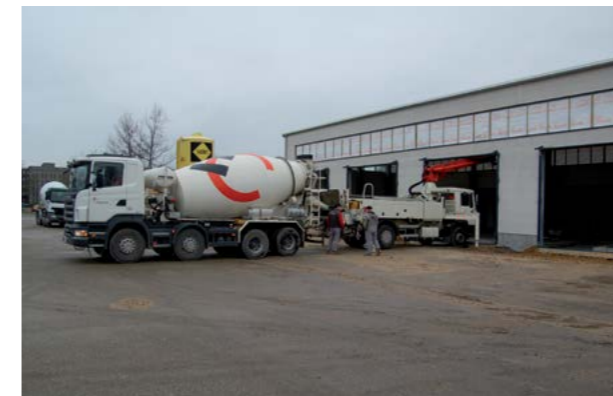
Abb. 7.8.8 Fahrmischer bei der Übergabe auf die Betonpumpe
