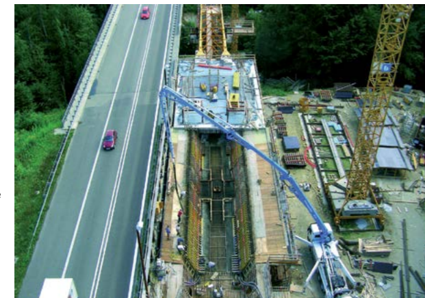
Abb. 4.2.5 (rechts) Fahrmischer und Pumpe von Holcim im Einsatz
