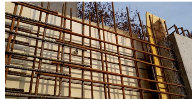
Abb. 8.13.13 Frischbetonverbundfolie bei Ortbeton
