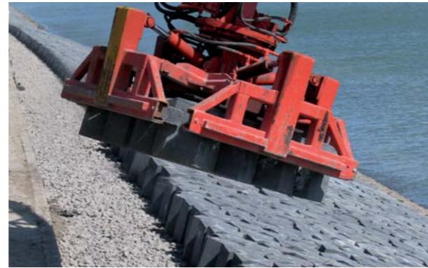
Abb. 9.6.1 Betonsäulen beim Verlegen
