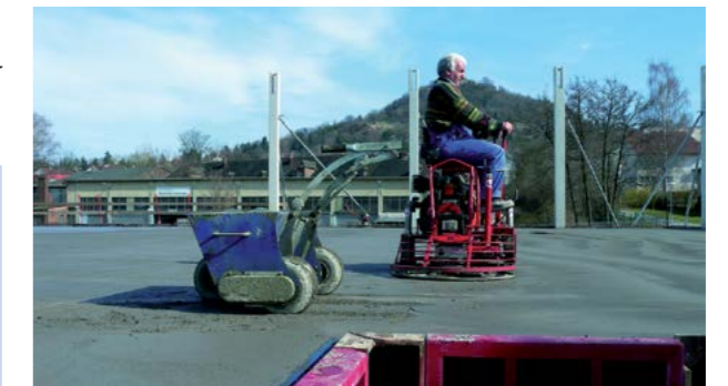
Abb. 8.4.39 Flügelglätten mit Hartkorneinstreuung
