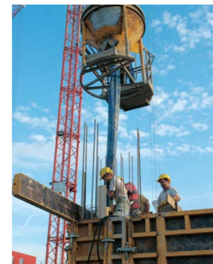
Abb. 8.13.14 Betonierkübel mit Schlauch
