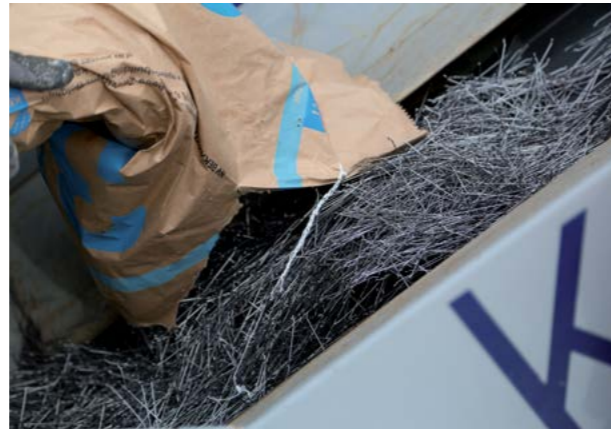
Abb. 8.16.1 Stahlfaserdosierung am Fahrmischer
