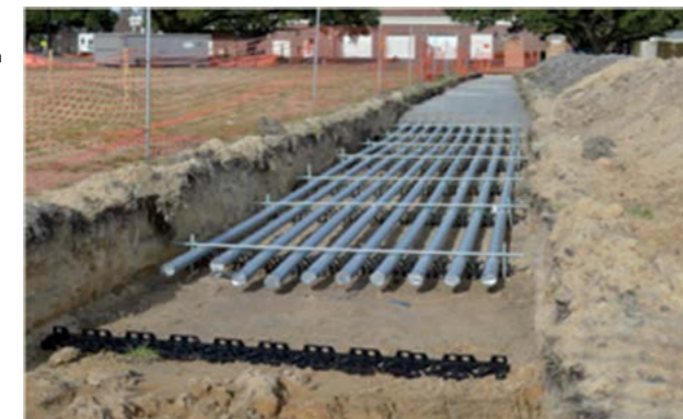
Abb. 7.17.2 (links) Wärmeleitfähiger Beton zur Verfüllung von Rohrleitungsgräben
