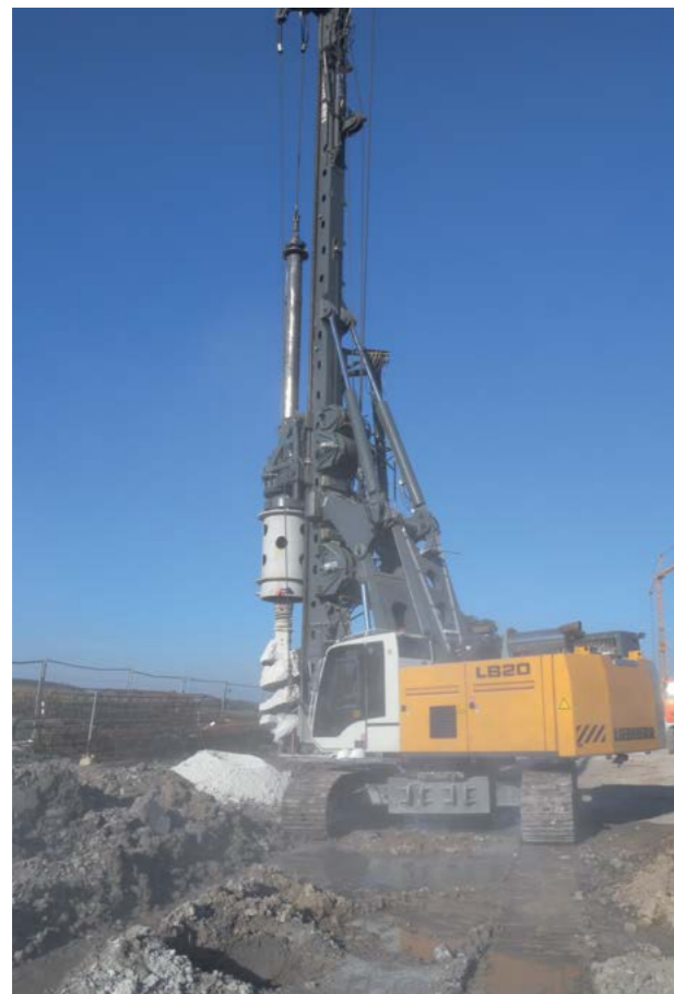
Abb. 8.8.10 (rechts u.) Große Baustelle bei der Erstellung von Bohrfählen
