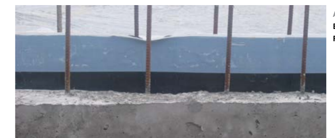
Abb. 8.13.12 Beschichtetes Fugenblech
