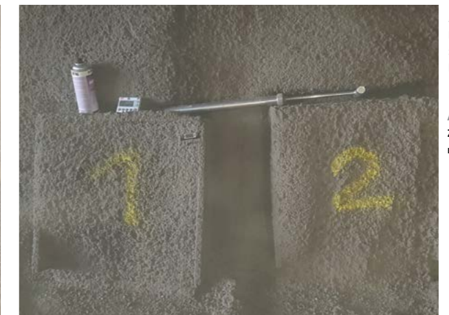
Abb. 7.10.11 (links) Herstellen einer Spritzkiste zur Messung der Festigkeitsentwicklung
