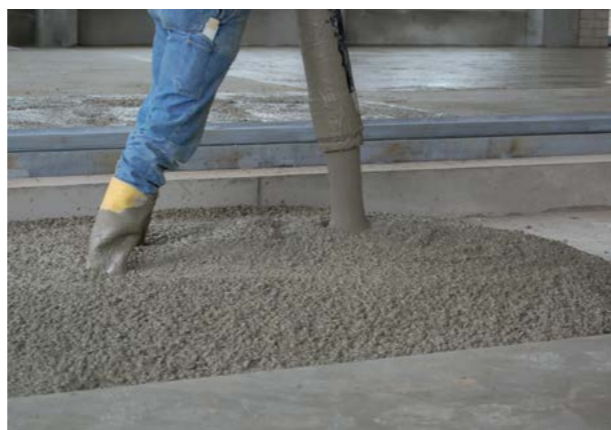
Abb. 8.16.3 Stahlfaserbeton – Frischbeton beim Einbau mit der Pumpe
