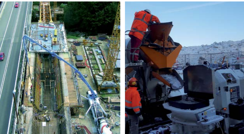
Abb. 8.15.2 (rechts) Winterbetonage mit einer stationären Betonpumpe
