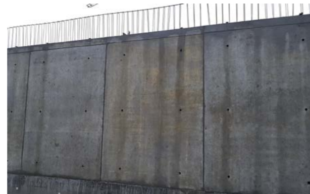
Abb. 10.2.13 Verfärbungen an der Betonoberfläche durch Phenolharz
