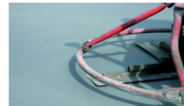
Abb. 8.4.37 Flügelglätten der Betonoberfläche - bei LP-Beton nicht glätten!
