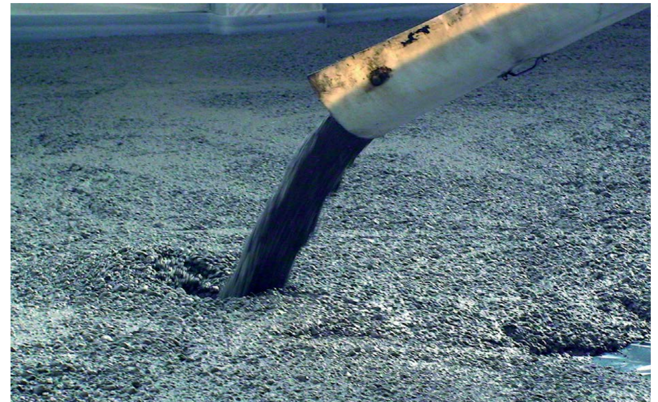
Abb. 7.4.8 LVB - Konsistenzklasse F5 / F6 direkt aus dem Fahrnischer
