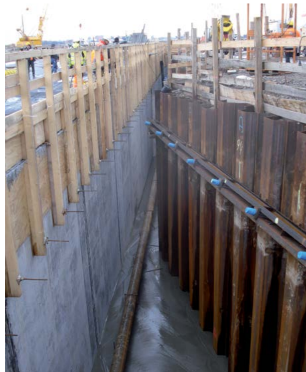
Abb. 8.17.2 Verfüllung eines Arbeitsraumes mit neuer Rohrleitung
