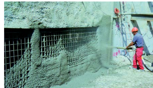
Abb. 7.10.7 Sicherung einer Baugrube mit Spritzbeton
