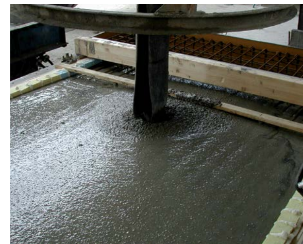
Abb. 7.4.2 Leichtverdichtbarer Beton vereinfacht den Einbau
