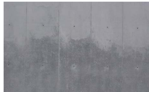
Abb. 10.2.17 Dunkelverfärbung der unteren Schüttele
