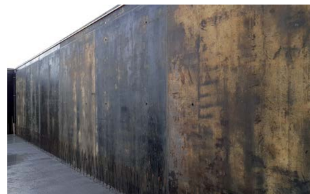
Abb. 10.2.12 Phenolharzbeschichtete Schalhaut
