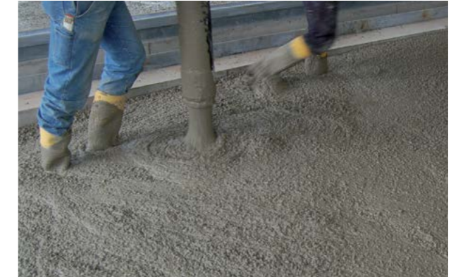
Abb. 7.8.10 Einbringen von Stahlfaserbeton
