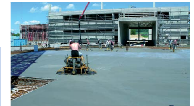
Abb. 8.4.38 Flügelglätten der Betonoberfläche
