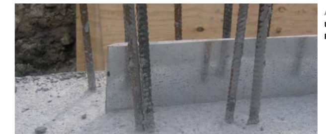
Abb. 8.13.11 Unbeschichtetes Fugenblech
