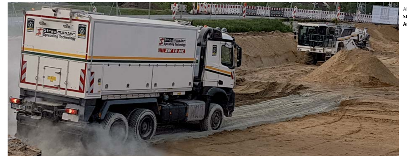
Abb. 8.18.9 Streufahrzeug bei der Arbeit
