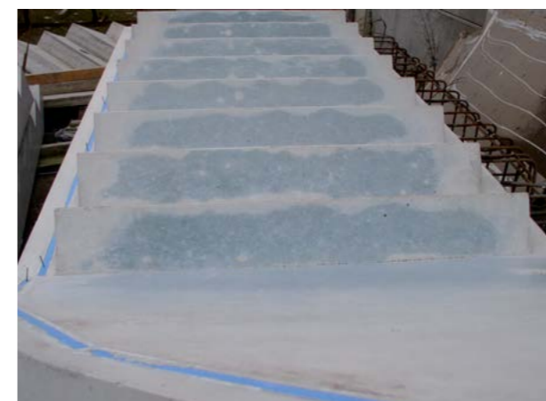
Abb. 10.2.20 Treppe mit Blaufärbung auf der geschalteten Oberfläche
