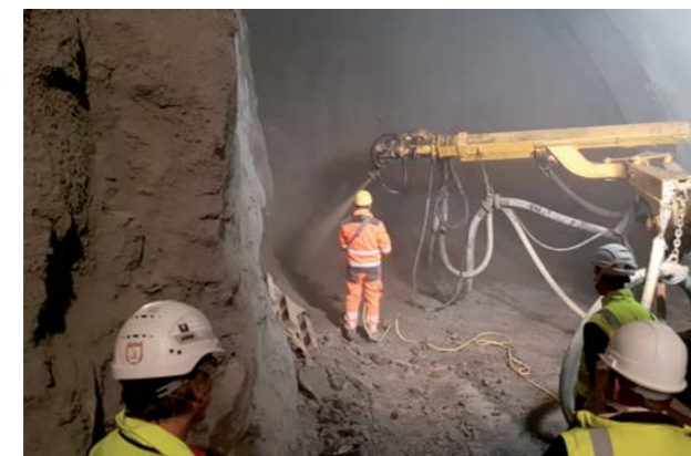
Abb. 7.10.6 (links) Spritzmobil im Einsatz bei der Tunnelsicherung
