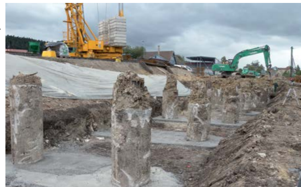
Abb. 8.8.2 (links) Erstellen von überstehenden Bohrpfählen
