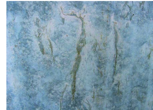
Abb. 8.3.11 Trennmittel zu dick aufgetragen- Fleckenbildung und Porenanhäufung
