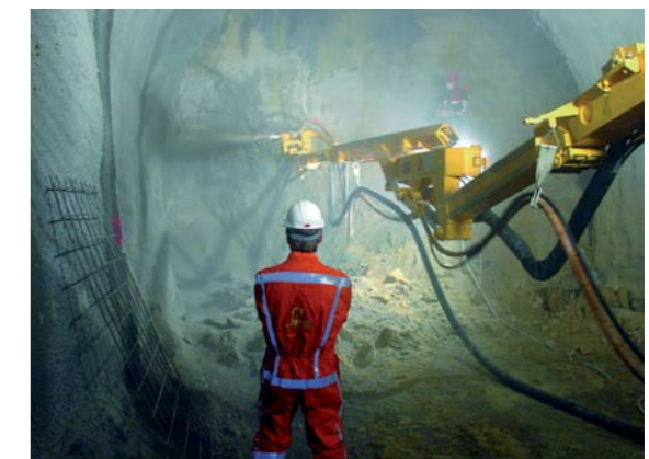
Abb. 7.10.5 Felssicherung mit Spritzbeton direkt beim Abbau
