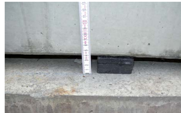
Abb. 7.1.11 (rechts) Abschalung der Aufständern
