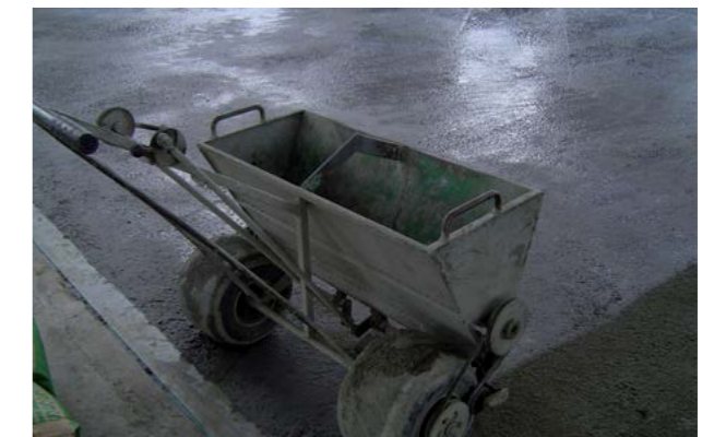
Abb. 8.14.5 Hartkornstreuung mit dem Streuwagen
