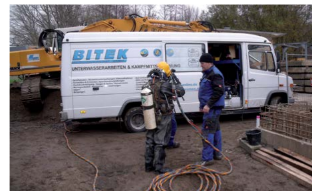
Abb. 8.12.3 (links) Taucher begleiten die Unterwasserbetonage
