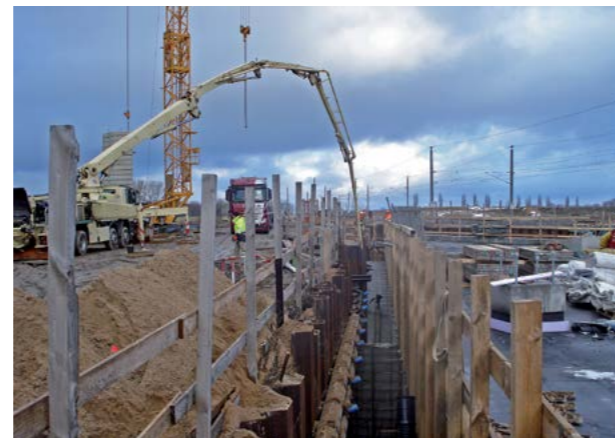
Abb. 8.17.3 Einsatz einer Pumpe bei großvolumiger Bauwerkshinterfüllung
