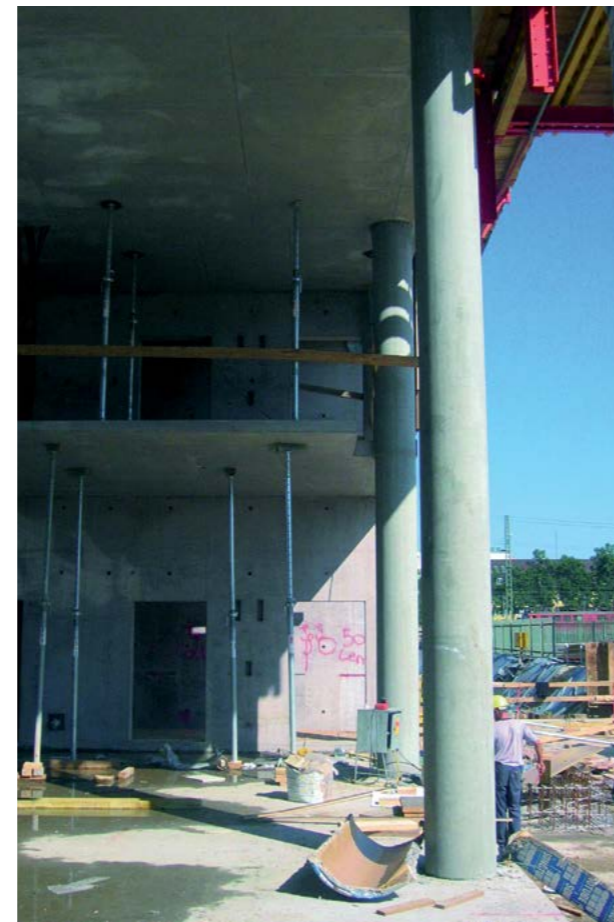
Abb. 7.9.2 Über zwei Stockwerke reichende Stützen, die hohen Lasten widerstehen müssen
