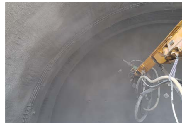
Abb. 8.7.1 Spritzbeton mit dem Spritzmobil aufgebracht
