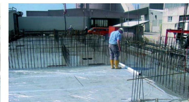
Abb. 5.2.12 Wasserhaltende Nachbehandlung mit Folie
