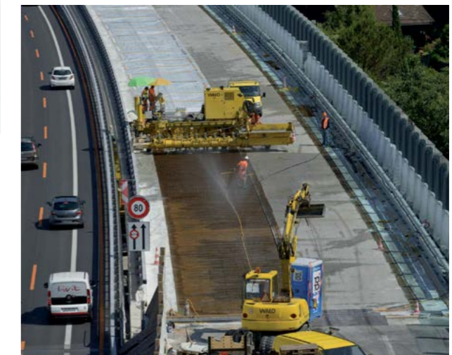
Abb. 7.13.4 Anwendung bei Brückensanierung
