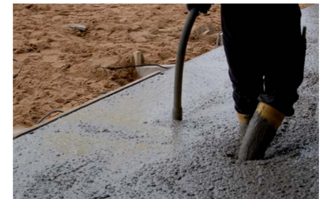
Abb. 7.8.11 Verdichten von Stahlfaserbeton
