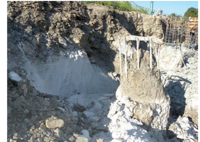
Abb. 10.6.3 Bohrfähle mit SR-Zement im gipshaltigen Boden
