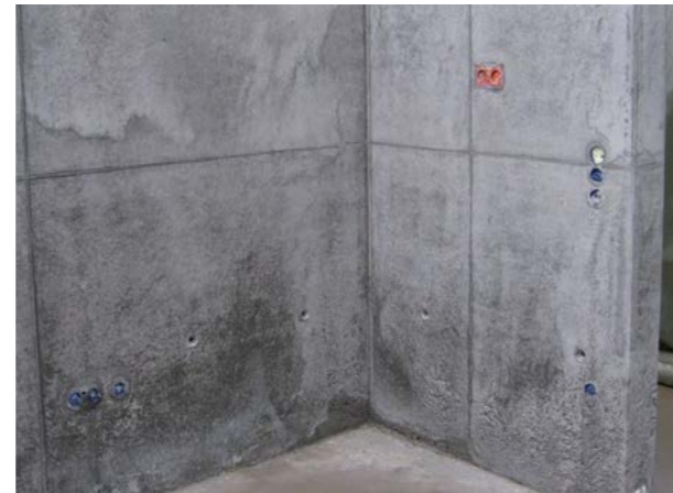
Abb. 8.3.6 Herstellung von Sichtbeton bei ungünstigen Umweltbedingungen (kalt, nass)
