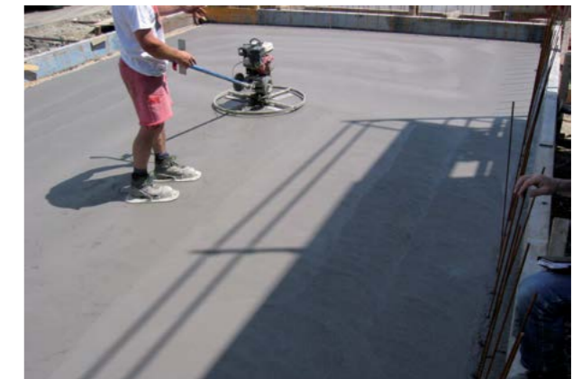
Abb. 8.14.7 Unterschiedliches Abbindeverhalten der Betonoberfläche
