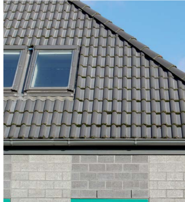
Abb. 9.3.2 Dachstuhl mit Betondachsteinen
