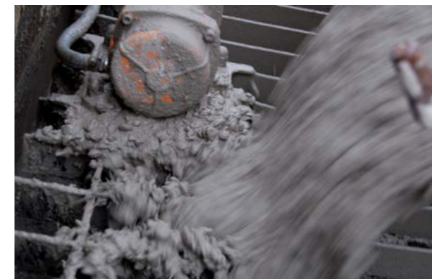
Abb. 7.8.9 Übergabe von Stahlfaserbeton auf die Betonpumpe
