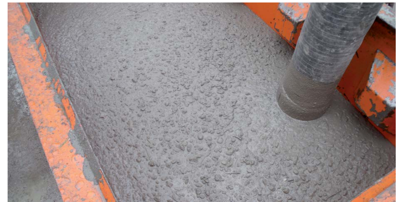
Abb. 8.12.7 Befüllung eines LEGO-Steins mit Unterwasserbeton
