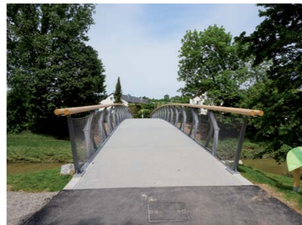
Abb. 9.5.4 Integrale Holzbrücken Remstal-2, Bild: solidian GmbH
