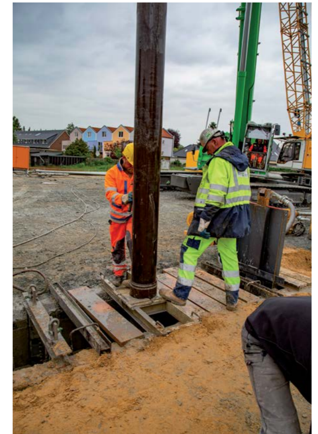
Abb. 8.9.1 (links) Ausheben einer Schlitzwand
