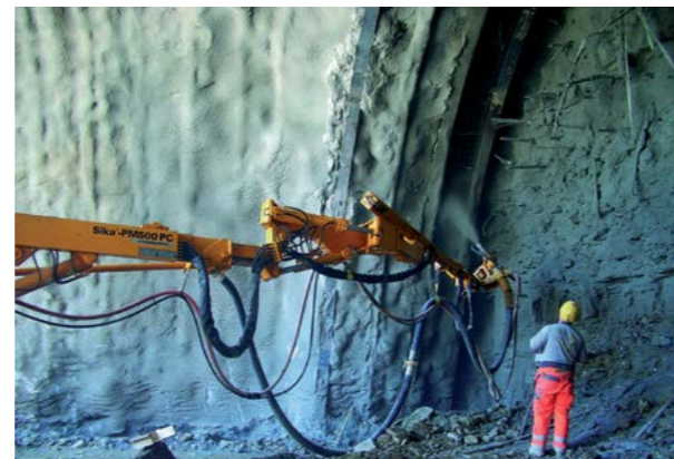
Abb. 7.10.8 Sicherung des Gebirges mit Spritzbeton
