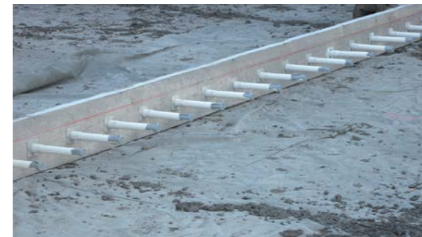
Abb. 8.4.20 und Abb. 8.4.21 Pressfuge/Arbeitsfuge
