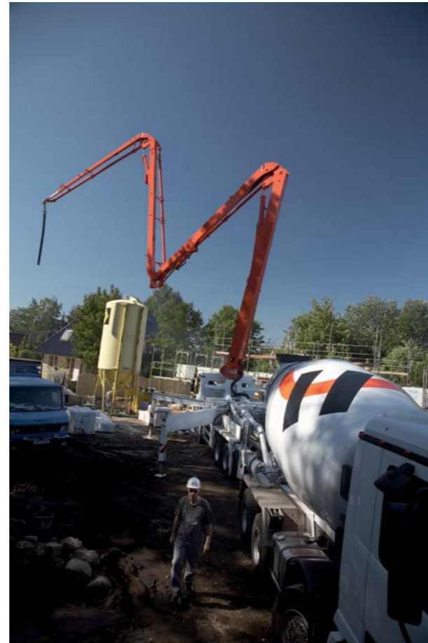
Abb. 4.2.6 Einrichten der Betonpumpe auf der Baustelle
