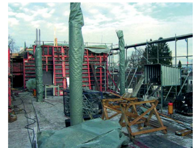
Abb. 5.3.11 Schutz des Betons vor Auskühlung durch belassen in der Schalung und Abdecken der Oberfläche mit Folien
