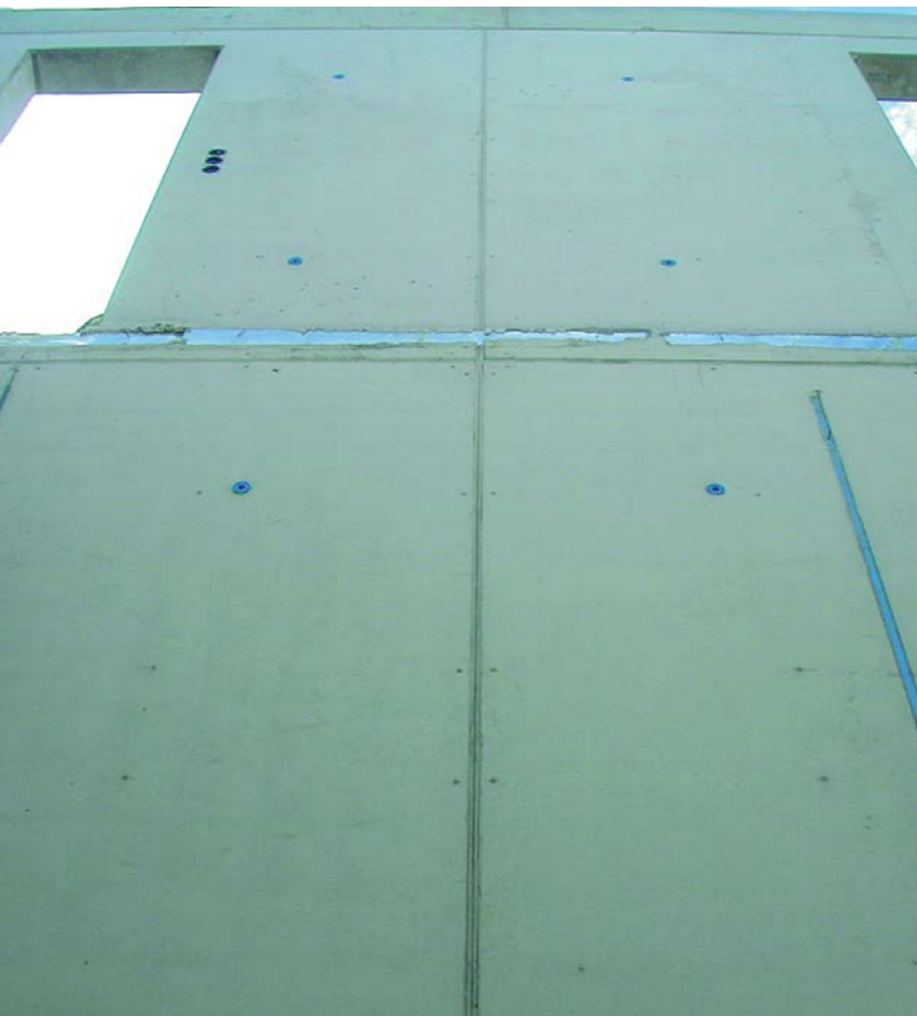
Abb. 7.5.1 Wohnhaus in SVB ausgeführt
