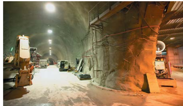
Abb. 7.10.8 Sicherung des Gebirges mit Spritzbeton
