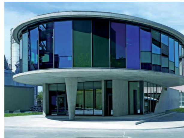
Abb. 8.3.9 Leitstand Holcim (Süddeutschland) GmbH
