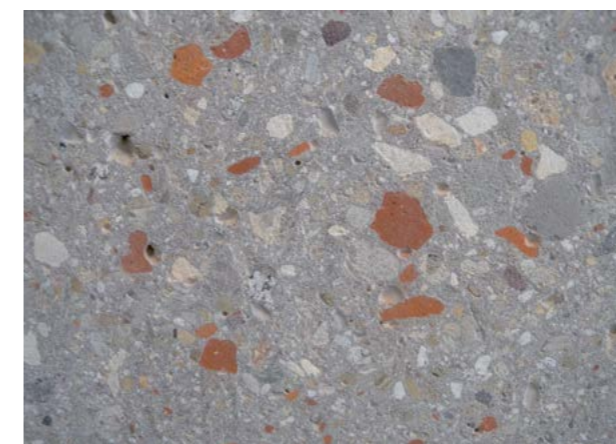
Abb. 1.4.3 Geschliffene R-Betonoberfläche mit RC-Körnung Typ 2
