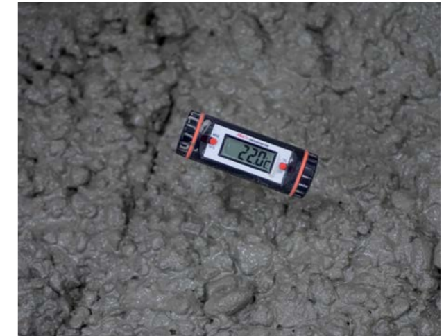
Abb. 5.3.10 Halten der Frischbetontemperatur über 10 °C für mind. 3 Tage
