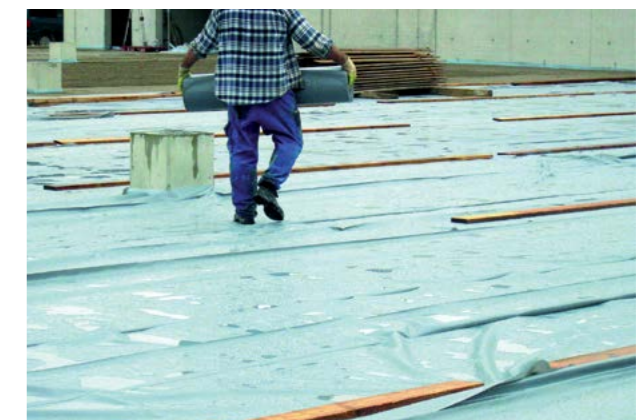
Abb. 5.3.7 Abdecken mit Kunststofffolien und sichern durch Bretter
