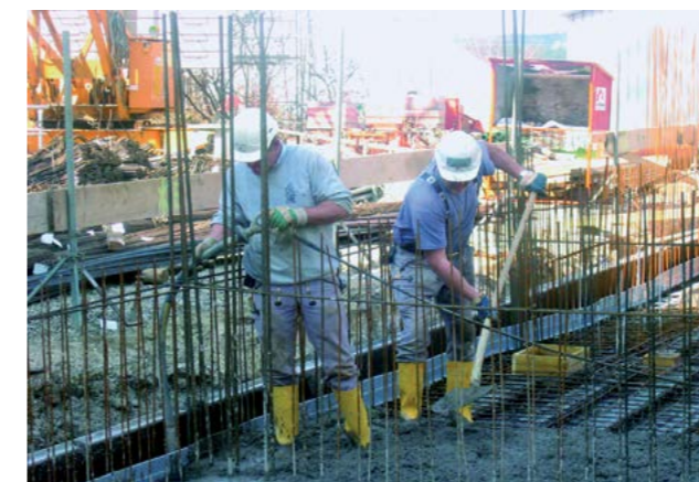
Abb. 5.1.6 Verdichten von Frischbeton
