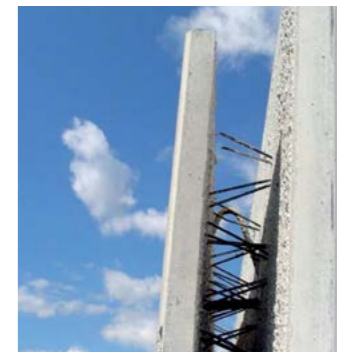
Abb. 7.1.7 Elementwände mit Ortbetonergänzung
