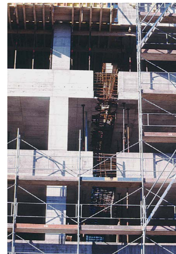
Abb. 10.3.2 Schwindgasse bei einem großen Gebäude
