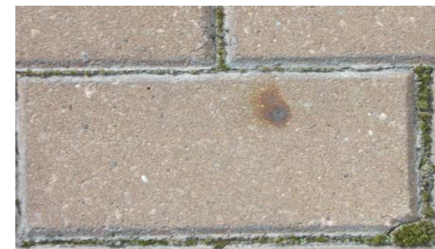
Abb. 10.2.16 Braunverfärbung durch Pyrit im Vorsatz eines Pflastersteins
