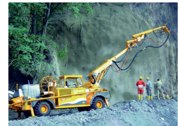
Abb. 7.10.4 Trockenspritzen: Baugrubensicherung
