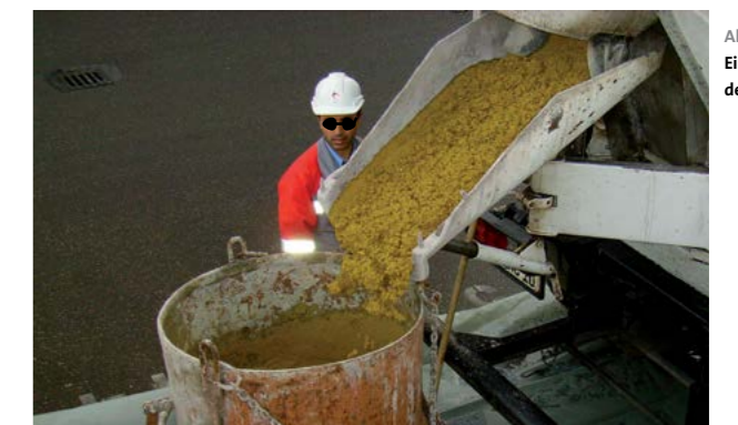
Abb. 1.6.3 Eingefärbter Beton aus dem Fahrmischer
