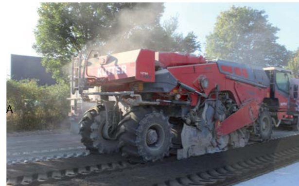
Abb. 8.18.2 Maschine beim Ausstreuen von Bodenverfestigungsmaterial
