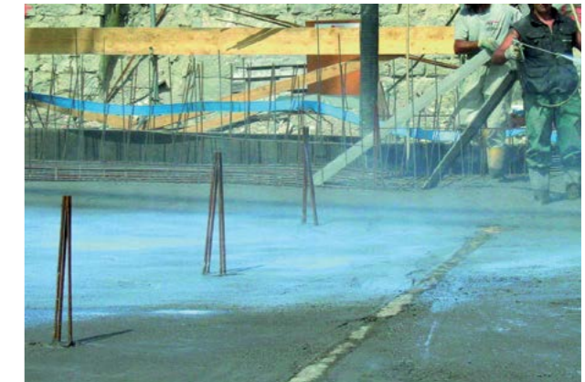
Abb. 5.3.6 Aufsprühen eines Nachbehandlungsmittels unmittelbar nach dem Einbringen
