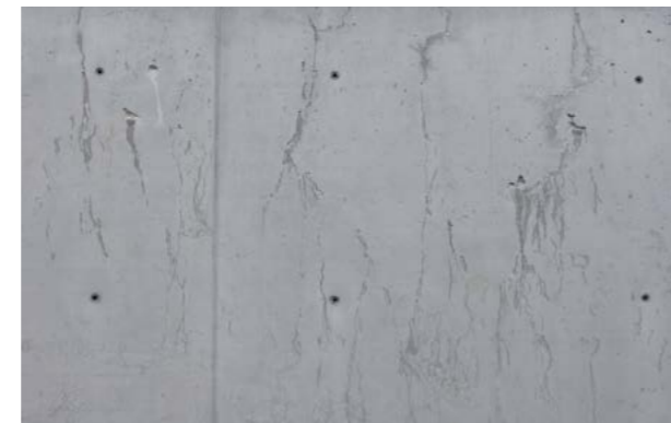
Abb. 10.1.2 Auswirkung von Wasserschliren auf das Aussehen der Betonoberfläche
