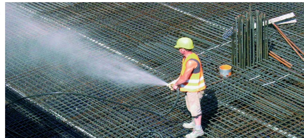
Abb. 5.3.5 Besprühen der Schalung und Bewehrung bei heißen Außentemperaturen
