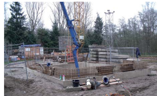
Abb. 8.12.1 (links) Betonage eines Unterwasserbauwerks
