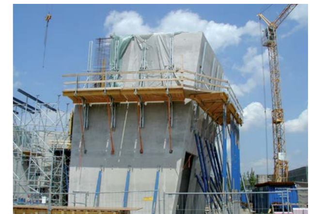
Abb. 7.6.7 Baustelle: Kirche aus Leichtbeton Freiburg - Umkirch
