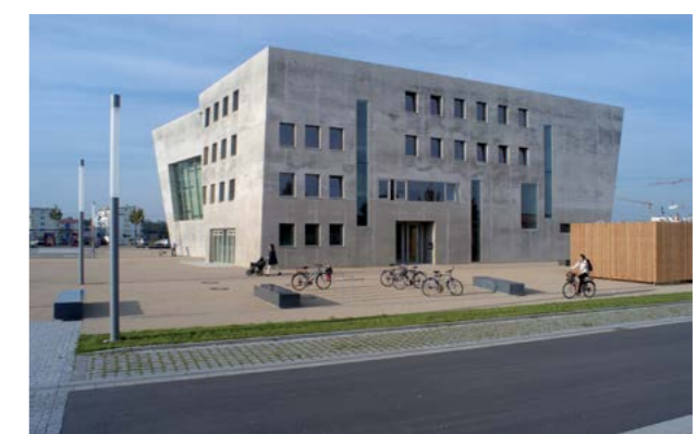
Abb. 7.6.8 Kirche aus Leichtbeton Freiburg - Umkirch
