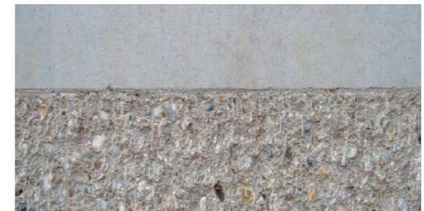
Abb. 8.3.20 Stocken einer Betonoberfläche
