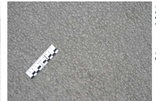
Abb. 8.6.4 (links) Autobahn aus Beton - Oberfläche mit Besen abgetragen
