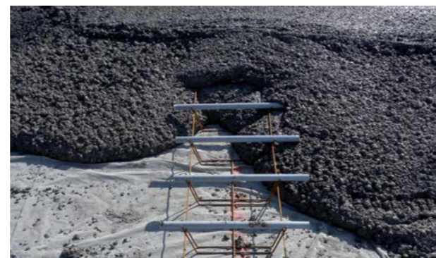
Abb. 8.4.19 Verdübelung durch Dübeleinlagekorb beim Betonieren
