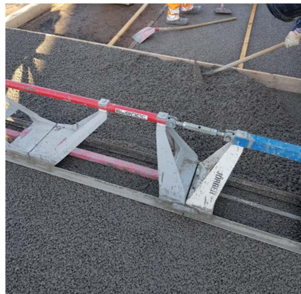
Abb. 7.11.1 Dränbeton beim Einbau, Abziehen mit der Rüttelbohle
