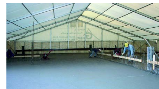
Abb. 5.2.10 Witterungsgeschütztes Arbeiten unter der Einhausung
