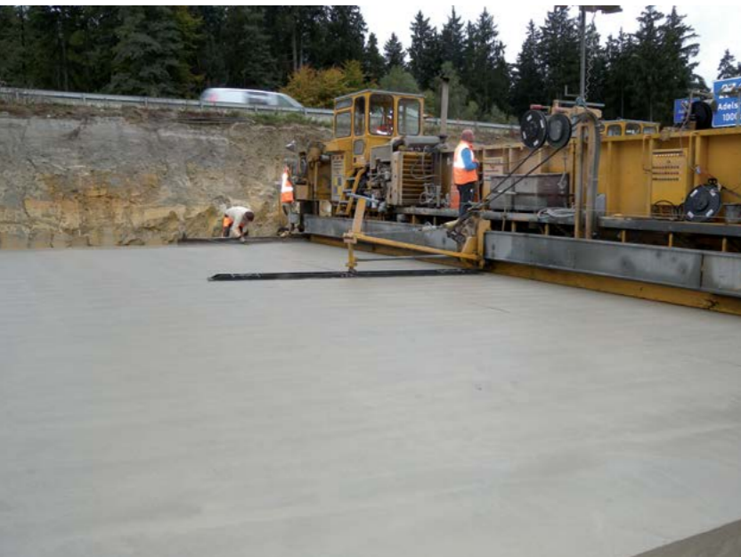
Abb. 8.6.1 Betonstraßenfertiger beim Betoneinbau
