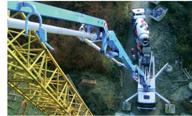
Abb. 8.15.4 Lange Pumpleitungen helfen beim Erreichen schwer zugänglicher Stellen
