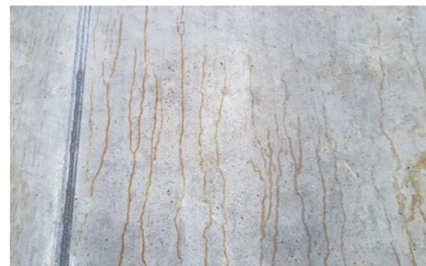
Abb. 10.2.13 Verfärbungen an der Betonoberfläche durch Phenolharz
