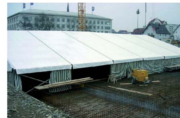
Abb. 5.2.9 Einhausungen bieten einen hohen Schutz vor unerwünschten Witterungseinflüssen
