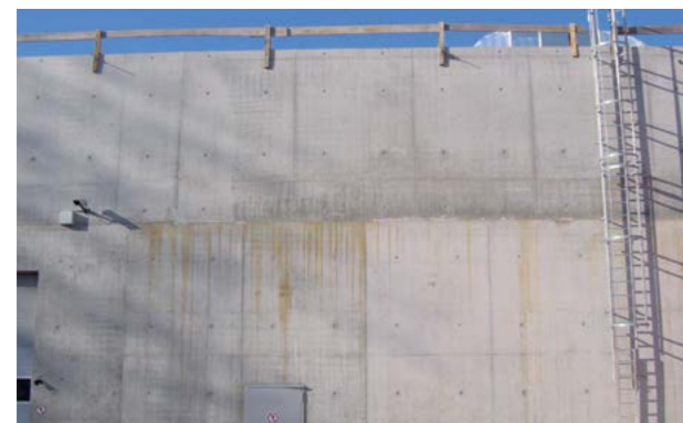
Abb. 10.2.14 (rechts) Braunverfärbungen durch Phenolharz
