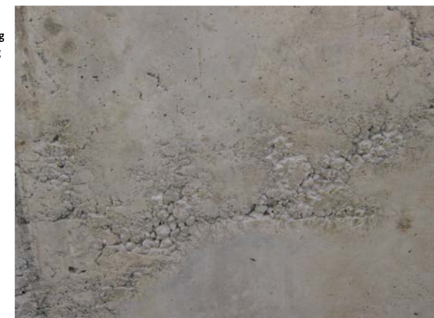
Abb. 10.1.3 (rechts) Unansehnliche Betonoberfläche infolge einer Mikroentmischung d. h. Entmischung des Zementmörtels in Zement und Feinsand
