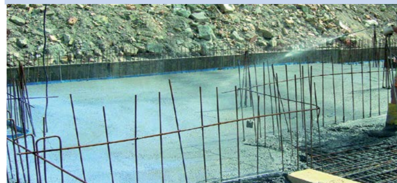
Abb. 5.2.3 Aufsprühen eines Nachbehandlungsmittels
