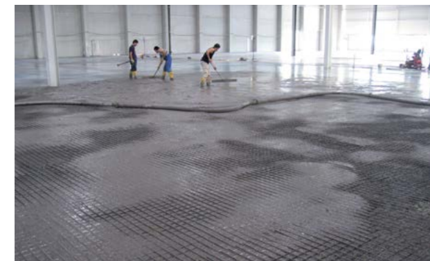
Abb. 8.4.9 Industriebodensystem in zwei Schichten: nass in nass
