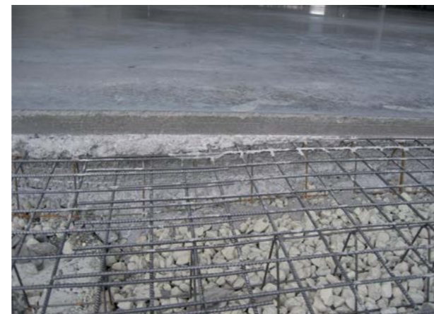
Abb. 8.4.4 Industriebodenaufbau im System
