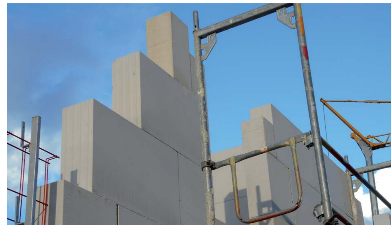
Abb. 9.4.3 Porenbeton im Wohnungsbau
