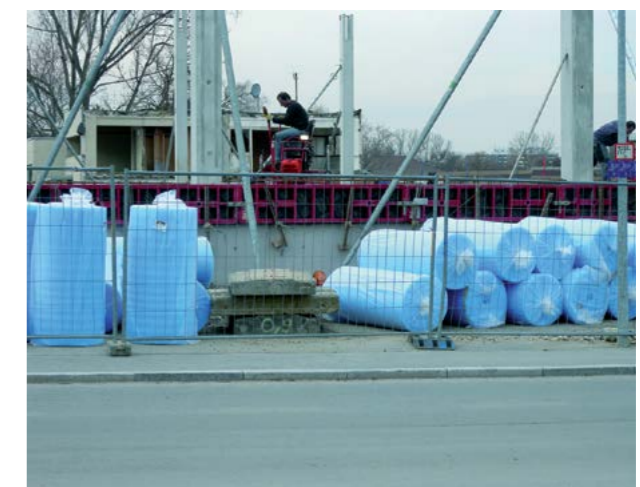
Abb. 5.3.12 Vorhalten von Wärmedämmmatten zur thermischen Nachbehandlung
