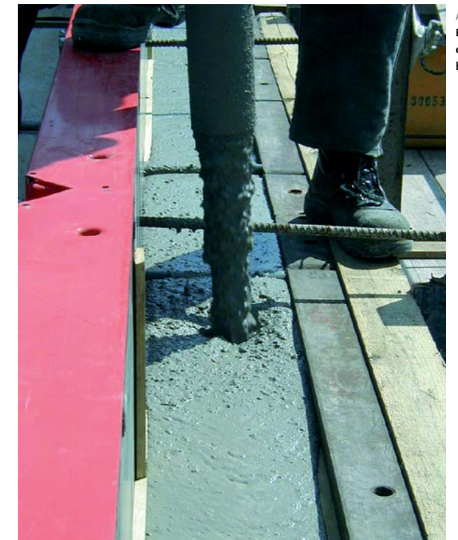
Abb. 7.5.13 Eine Person genügt, um eine Wand mit SVB zu betonieren
