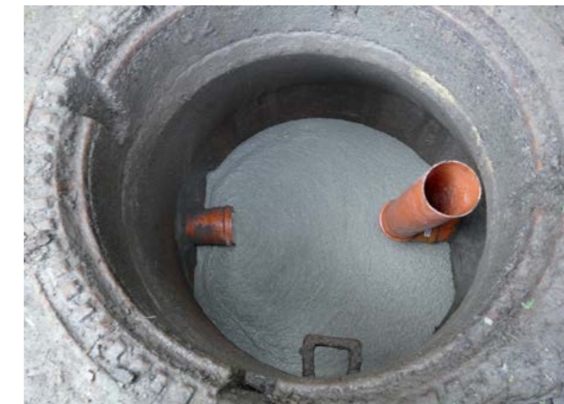
Abb. 8.17.5 Ringraumverfüllung nach Einzug einer neuen Rohrleitung in den alten Kanal
