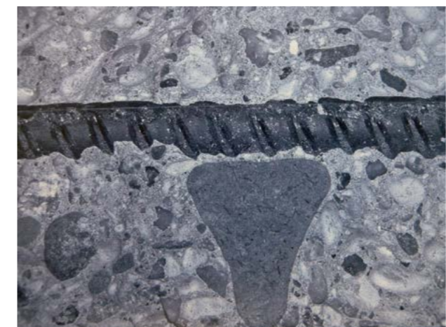
Abb. 3.4.2 Abstandhalter sorgt für ausreichende Betondeckung
