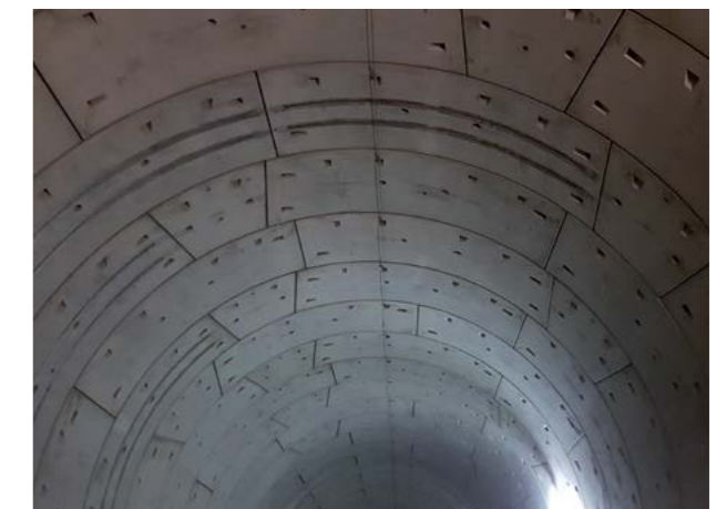
Abb. 8.7.5 Tübbinge im Gewölbe verbaut
