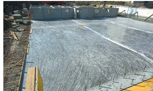
Abb. 5.2.1 Abdecken einer Betonplatte mit Folie
