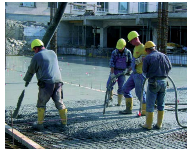
Abb. 7.4.2 Leichtverdichtbarer Beton vereinfacht den Einbau
