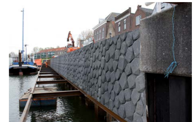
Abb. 9.6.3 (links) Betonblockmatten beim Verlegen
