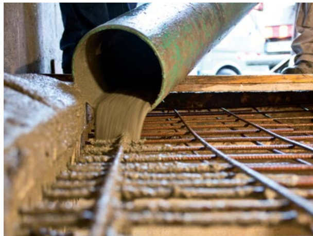
Abb. 8.17.7 Verfüllung über Rohrleitung
