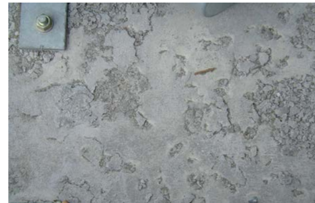
Abb. 10.4.2 Frost-Tausalz-Schaden - Detail
