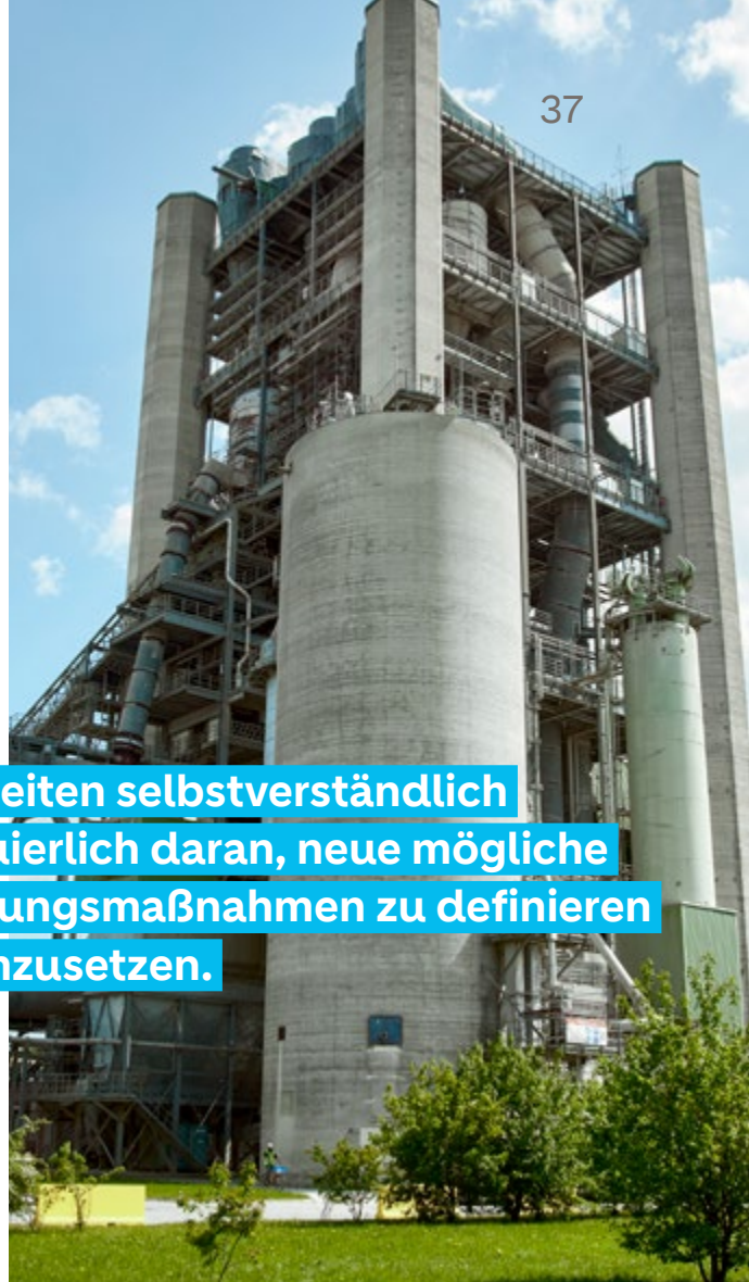
Drehofen mit Vorwärmerturm
