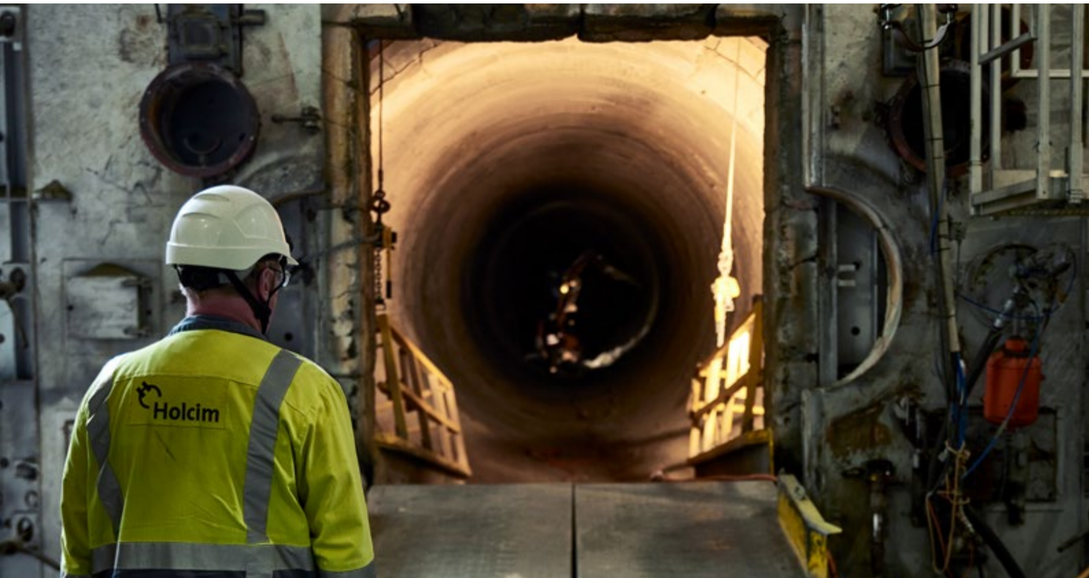
Stehender Drehofen bei Reparaturarbeiten.
